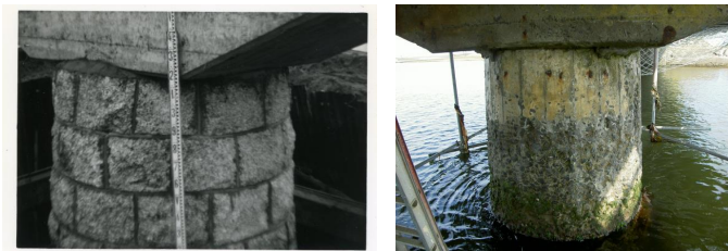
写真-10 施工当時
