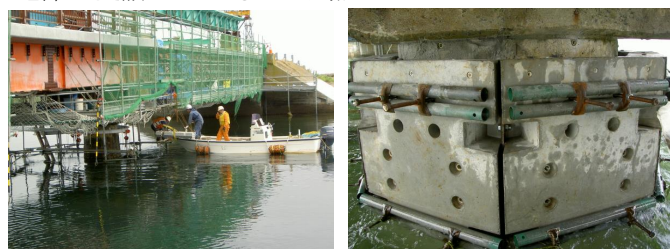
写真-12 P1 橋脚 PC パネル架設状況
