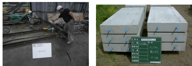
写真-8 PC パネル製作状況
