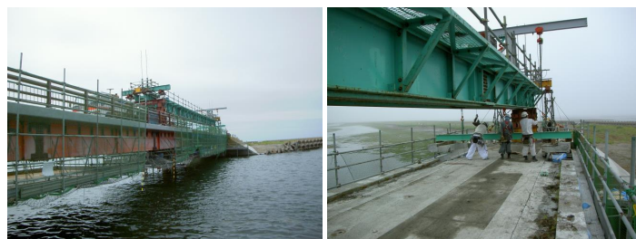
写真-5 既設床版撤去状況
