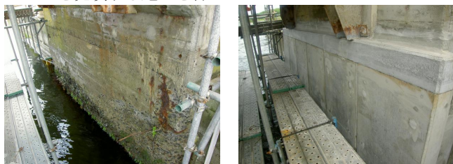
写真-7 A1 橋台 PC パネル設置前・設置後
