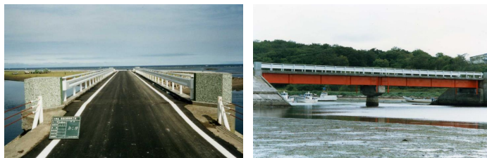
写真-2 現春国岱橋（昭和40年完成 昭和62年補修工事完成）
