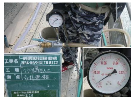
写真-5 減圧状態の確認
