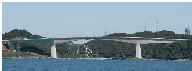
写真-1 彦島大橋全景
