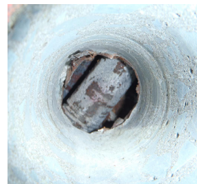
写真-4 φ50mm削孔確認
