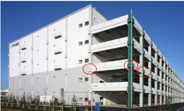
写真-1 PC 定着体突起の例
