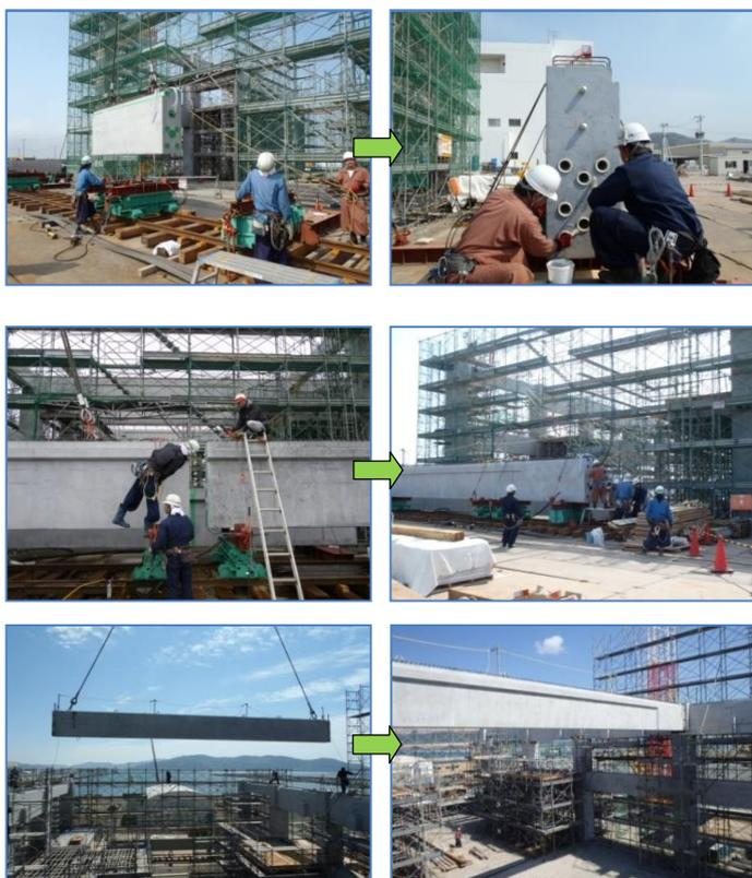
写真-2 連結梁施工状況
