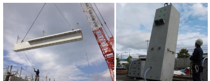
写真-6 部材架設状況
