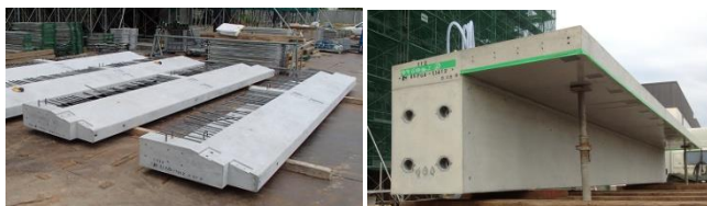
写真-3 プレキャスト化されたキャンチスラブ板
