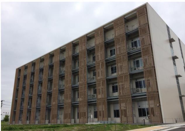
写真-2 建物外観（北面）
