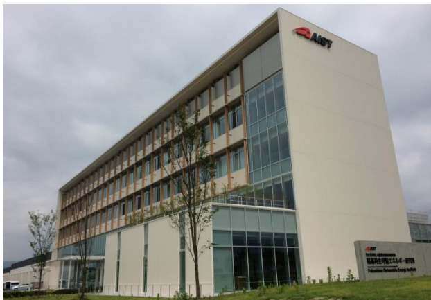
写真-1 建物外観（南面）
