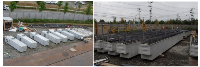
写真-5 仮置きヤード（先行搬入）
