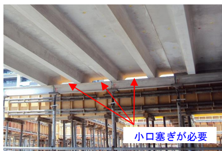
写真-1 従来のCS版取付後の納まり
