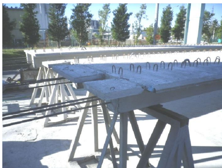
写真-2 小口塞ぎ板折り込み前の端部形状
