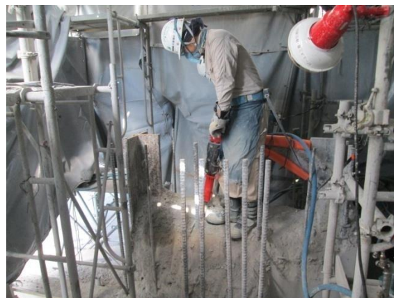
写真-18 柱新設部鉄筋はつり出し状況
