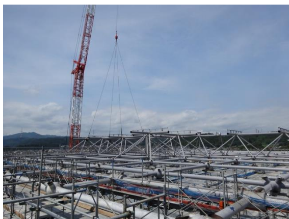
写真-11 トラス撤去状況
