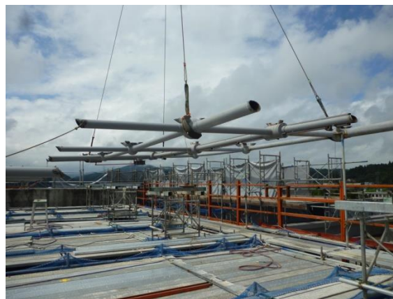
写真-14 下弦材撤去状況
