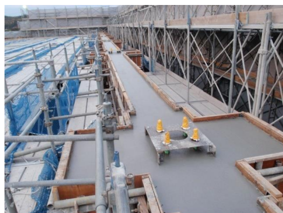
写真-20 コンクリート打設状況
