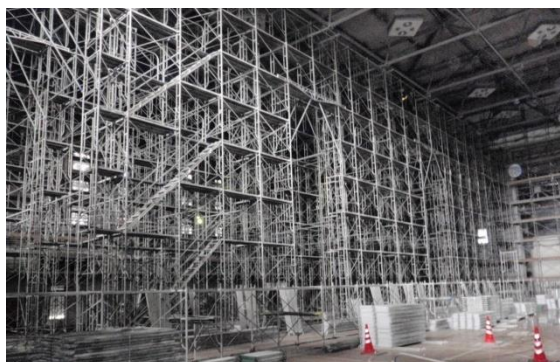
写真-5 内部足場組立状況
