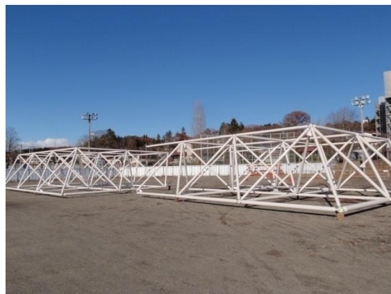
写真-21 トラス地組状況
