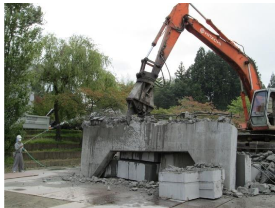
写真-16 梁解体状況
