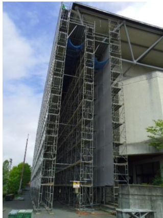
写真-6 外部足場架設状況
