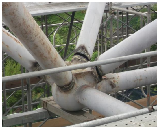
写真-10 部材ガス切断状況
