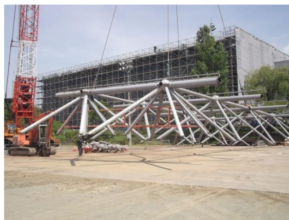
写真-12 トラス吊り降ろし状況
