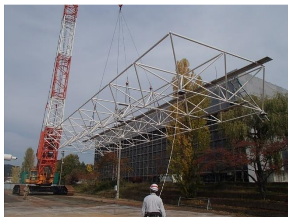
写真-22 トラス揚重状況
