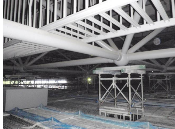
写真-7 内部ステージ足場架設状況
