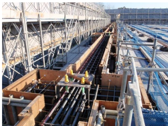
写真-19 柱梁配筋型枠状況
