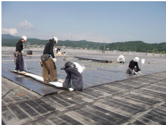
写真-8 屋根ステンレス板撤去状況
