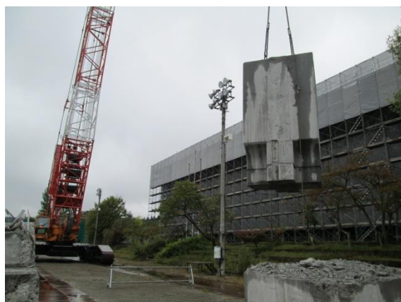
写真-17 柱切断後吊り降ろし状況
