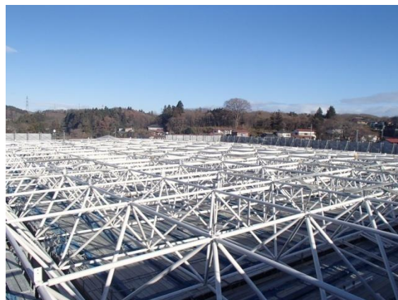
写真-23 立体トラス完成
