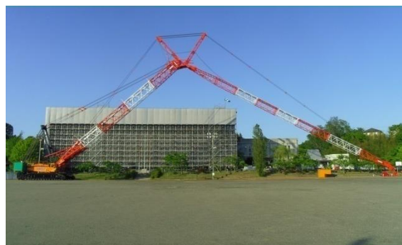
写真-4 クローラークレーン
