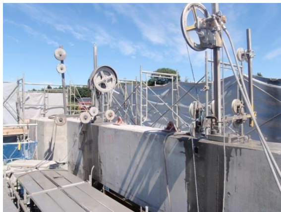
写真-15 梁ワイヤーソー切断状況
