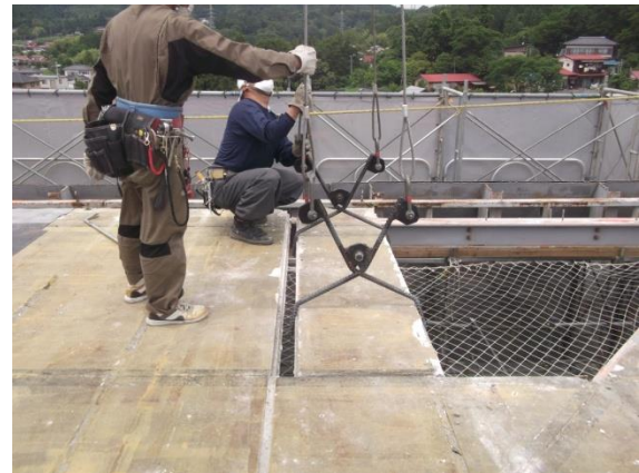
写真-9 屋根ALC版撤去状況
