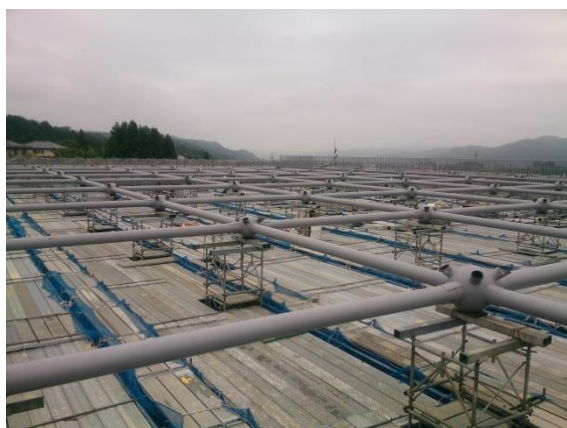
写真-13 上弦材・斜材撤去完了
