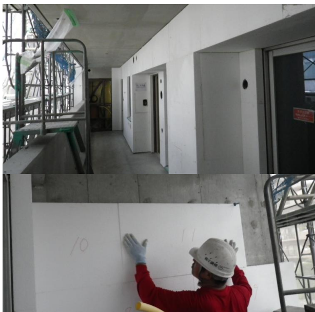
写真-1 施工状況
