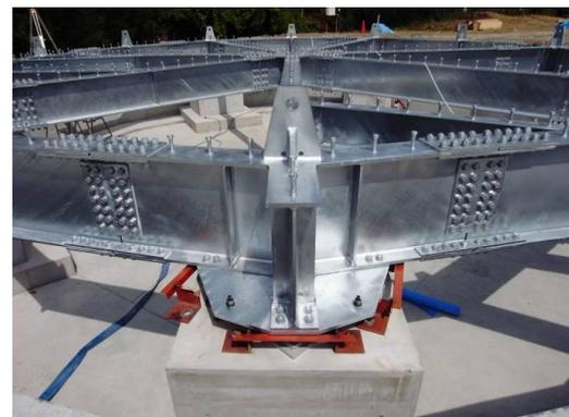
写真-4 免震ピット 基礎鉄骨梁は7カ所の免震装置で支持
