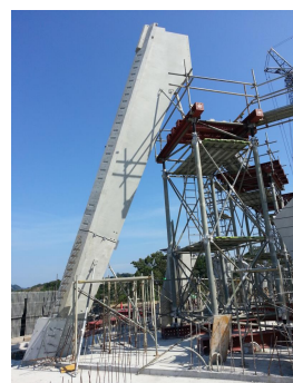
②柱上部材架設
