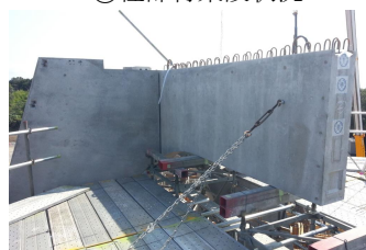
⑤梁部材架設状況
