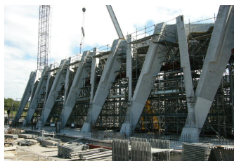
④柱部材架設状況
