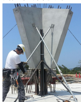
①柱脚部材架設
