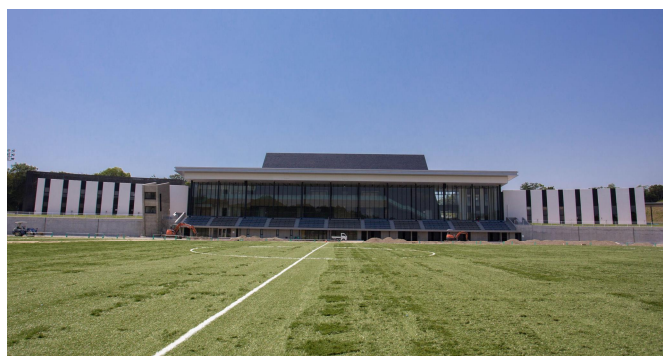
写真-1 完成写真
