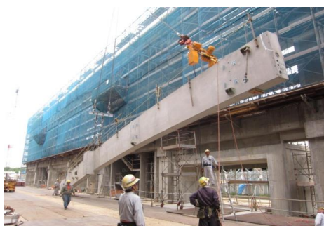
写真-4 角度調整状況
