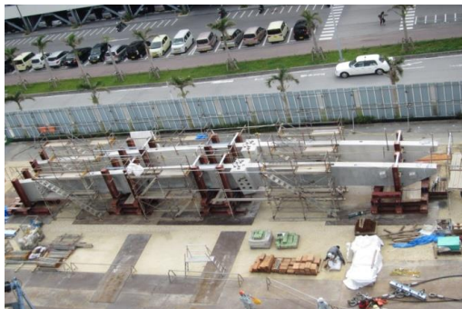
写真-2 地組ヤード
