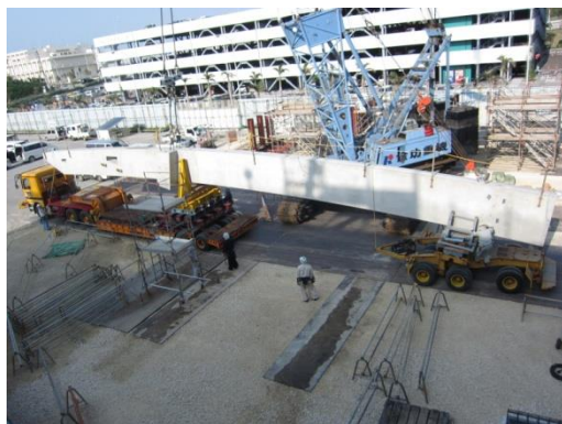
写真-3 場内運搬トレーラー積込み状況
