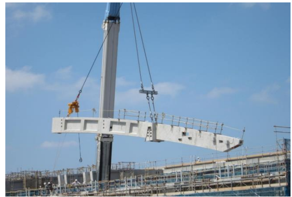
写真-5 ブロック①～③架設状況
