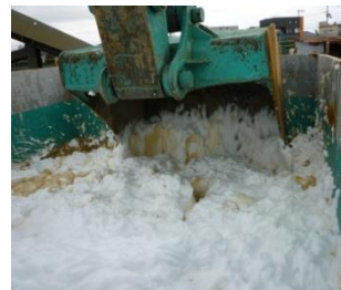
写真-3 気泡混合状況
