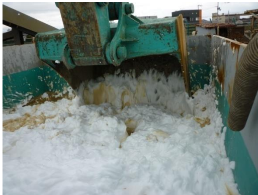
写真-4 気泡混合状況
