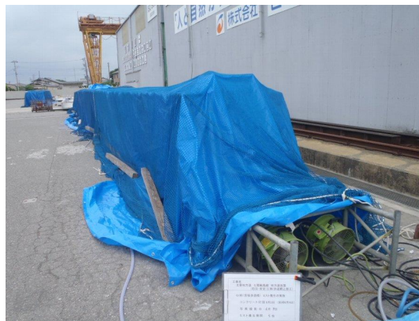
写真-1 ミスト養生状況
