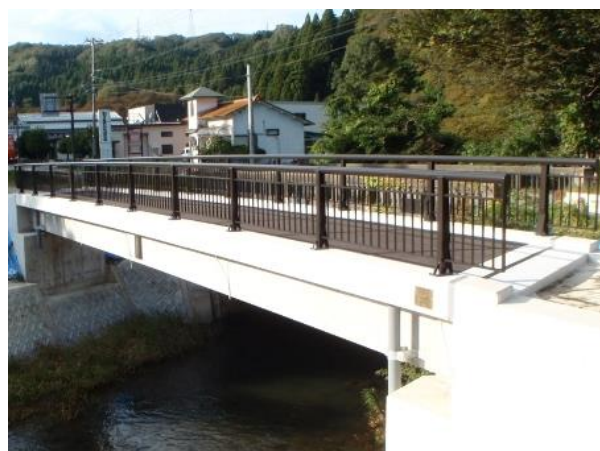
写真-3 完成した宮坂橋歩道橋
