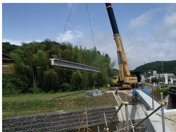
写真-2 架設状況
