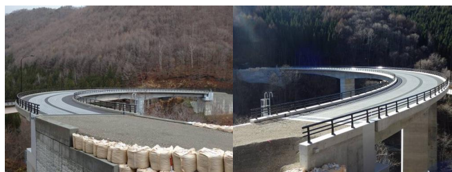
写真-4 起点側より
