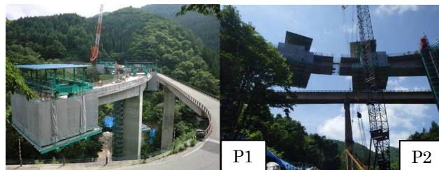
写真-1 張出し施工状況
