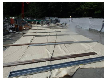
写真-3 床版養生状況
