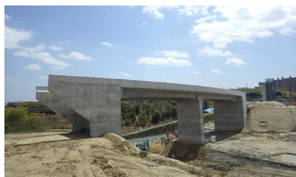
写真-1 橋体完成状況
