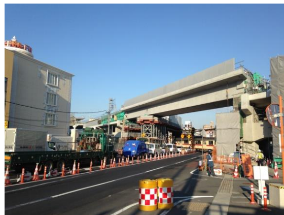
写真-1 架設状況
