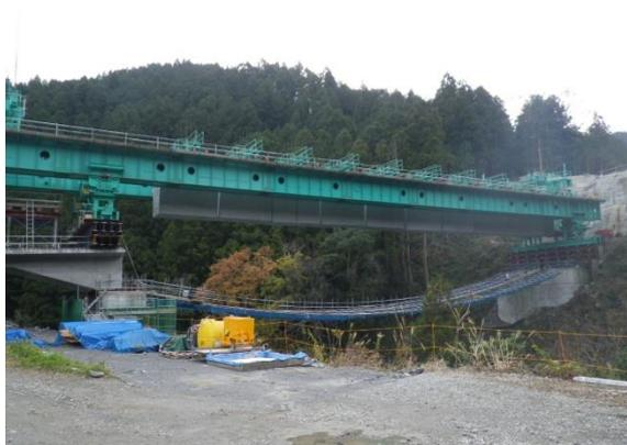
写真-1 主桁架設状況
