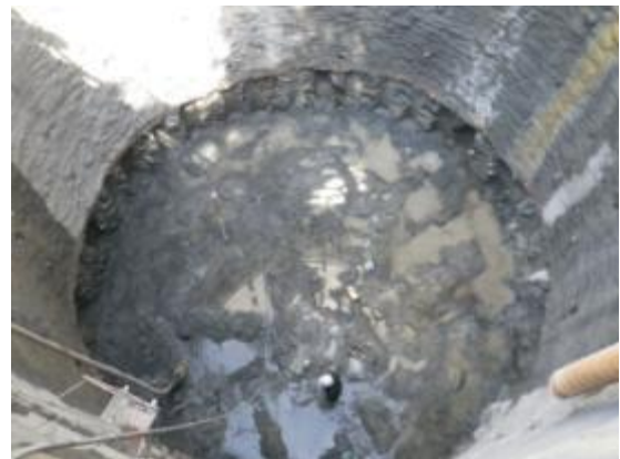
写真-3 掘削完了
