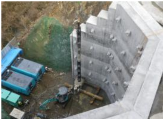
写真-1 ダウンザホールハンマーによる先行削孔
