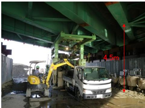
写真-1 場所打ち杭施工状況
