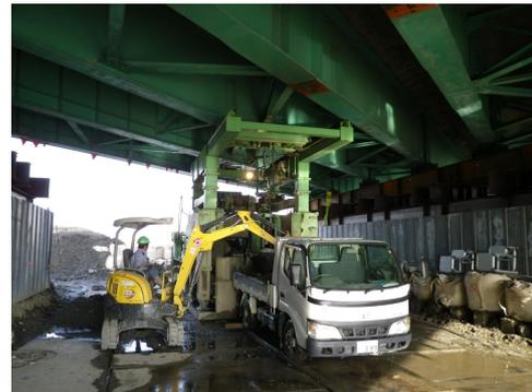
写真-2 場所打ち杭施工状況
