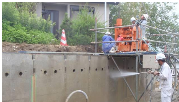
写真-3 間詰め部の構築状況
