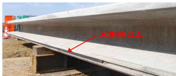
写真-2 水膨張ゴムの設置状況
