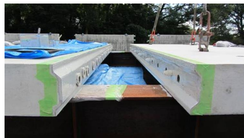
写真-1 床版縦目地構造(接合直前)
