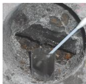
(2) 精製水による拭き取り
