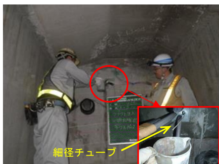
写真-4 補修材充填・充填確認状況
