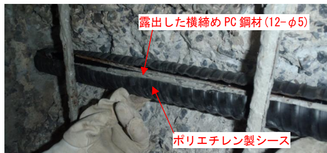
写真-2 シース復旧状況
