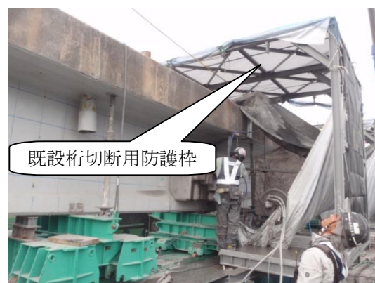
写真-4 既設桁切断用防護枠
