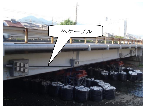
写真-2 外ケーブル補強された和瀬川橋(旧橋)
