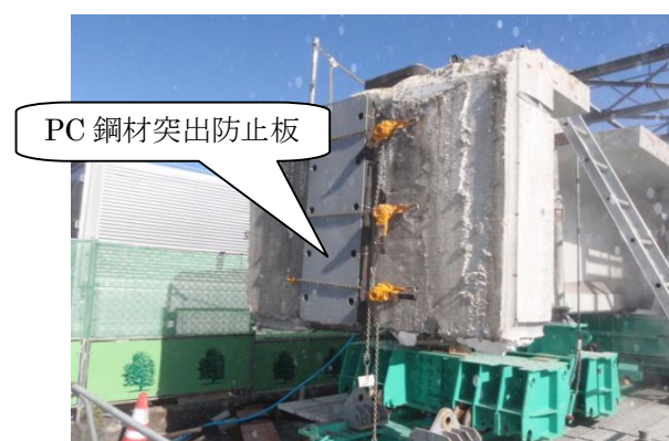
写真-3 PC鋼材突出防止工(主ケーブル桁端)
