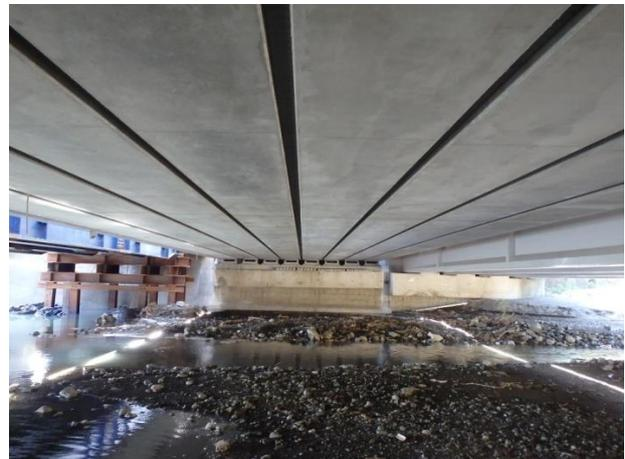
写真-9 下り線架替完了時（桁下）
