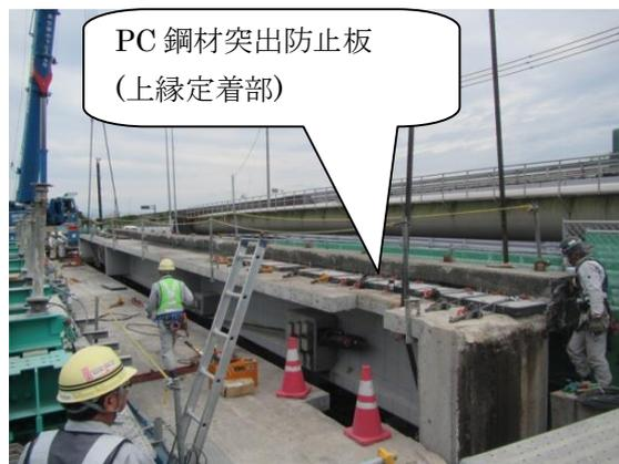
写真-5 PC鋼材突出防止工(主ケーブル上縁)
