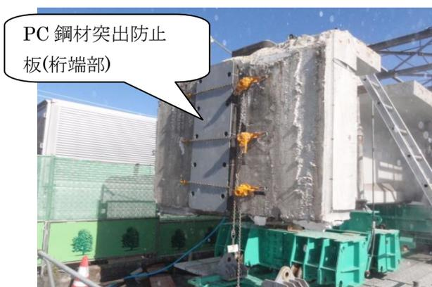
写真-6 PC鋼材突出防止工(主ケーブル桁端)
