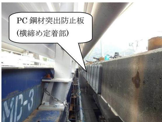
写真-4 PC鋼材突出防止工(横締め)
