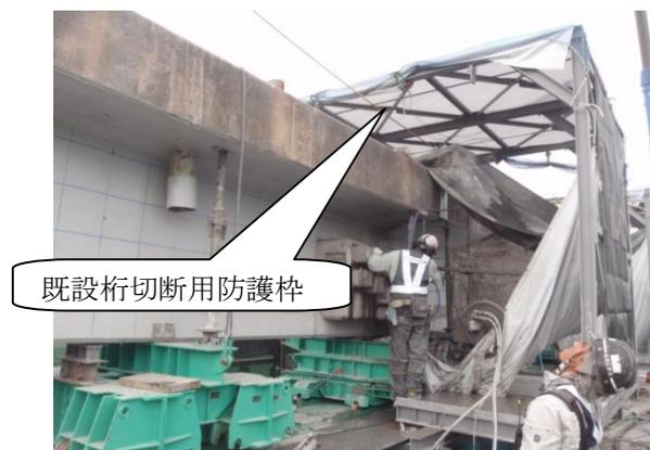
写真-7 既設桁切断用防護枠
