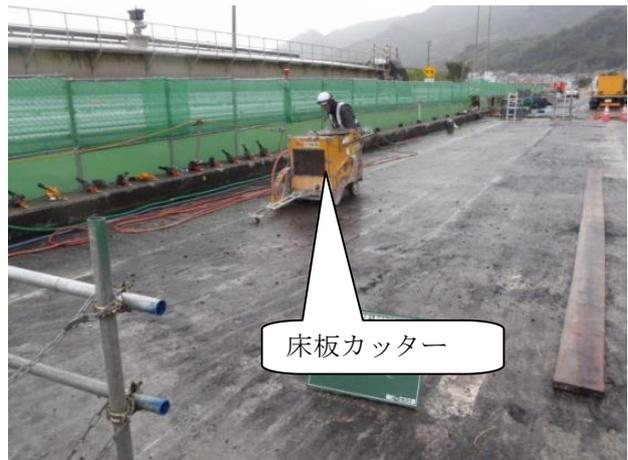
写真-3 床板切断(床板カッター)
