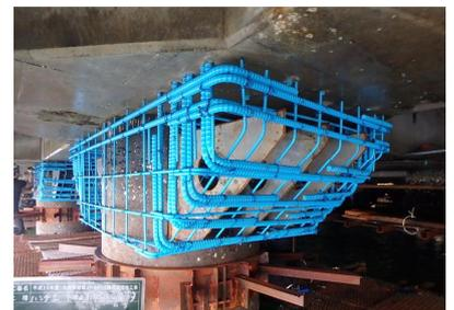
写真-3 ハンチ工鉄筋組立状況
