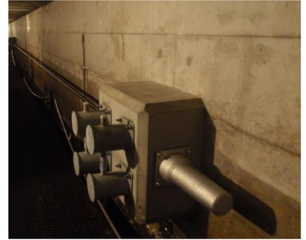
写真-2 第3バース外ケーブル工
