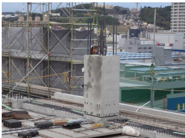
写真-2 柱の建て方状況
