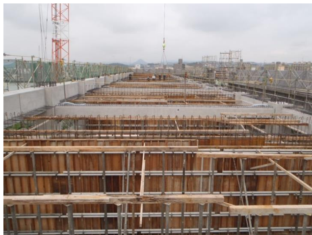
写真-5 場所打ち壁の鉄筋・型枠組立状況
