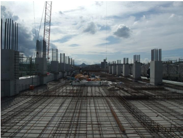
写真-8 場所打ち床の配筋状況
