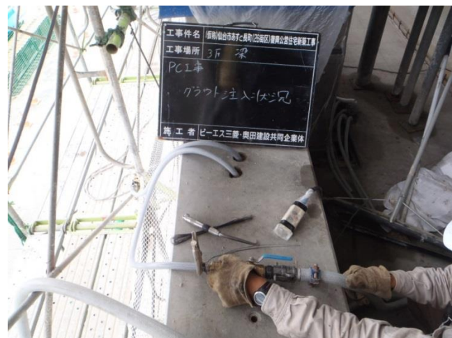
写真-11 桁行方向梁のPC グラウト充填状況
