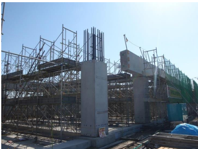
写真-4 桁行方向梁の架設状況
