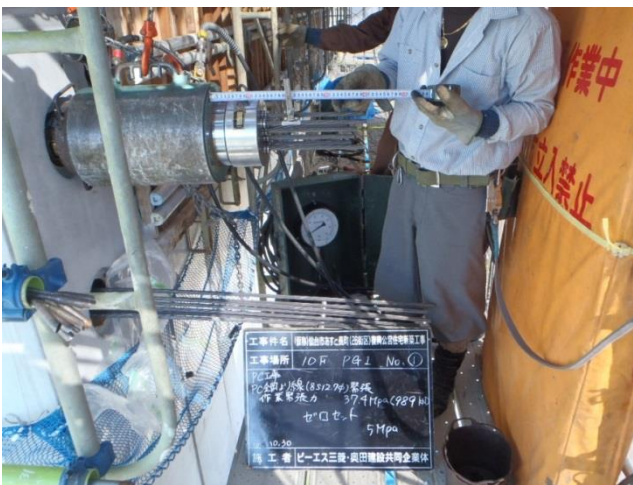
写真-10 桁行方向梁の緊張状況
