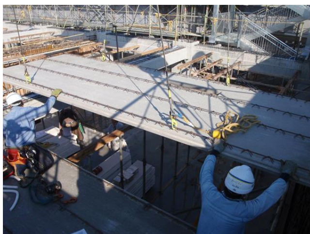
写真-6 ハーフ PCa 床板の架設状況
