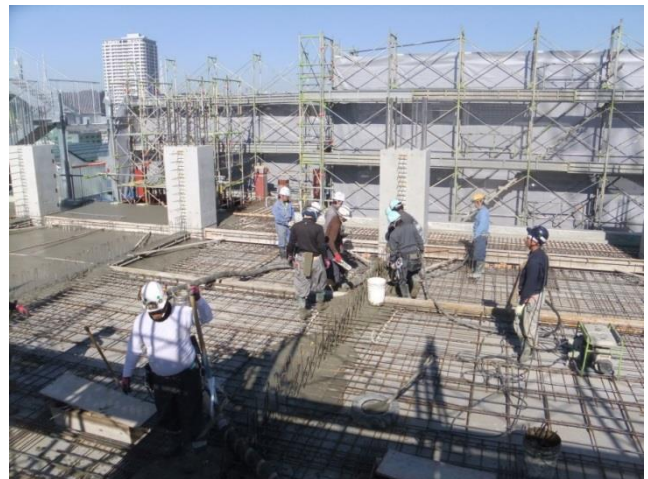
写真-9 床のコンクリート打設状況
