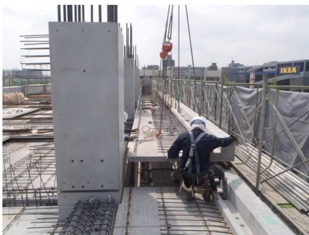
写真-7 ハーフ PCa 廊下板の架設状況
