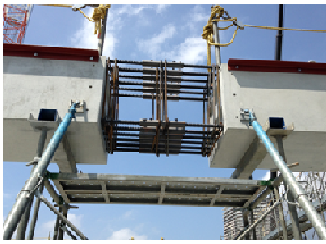
写真-3 桁梁中央部
