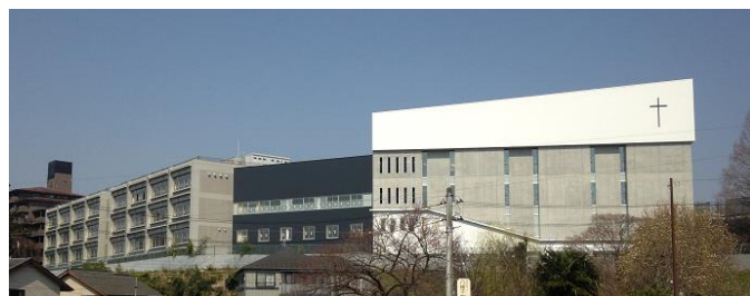
写真-1 校舎外観（南面）教室棟（左）
