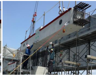
写真-4 桁梁架設状況
