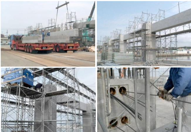
写真-4 梁部材架設状況
