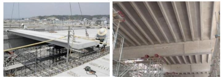
写真-6 DT床版施工状況
