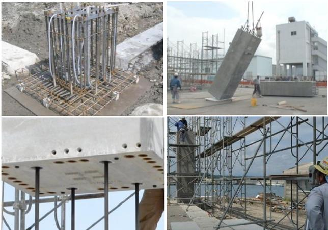
写真-3 柱部材架設状況
