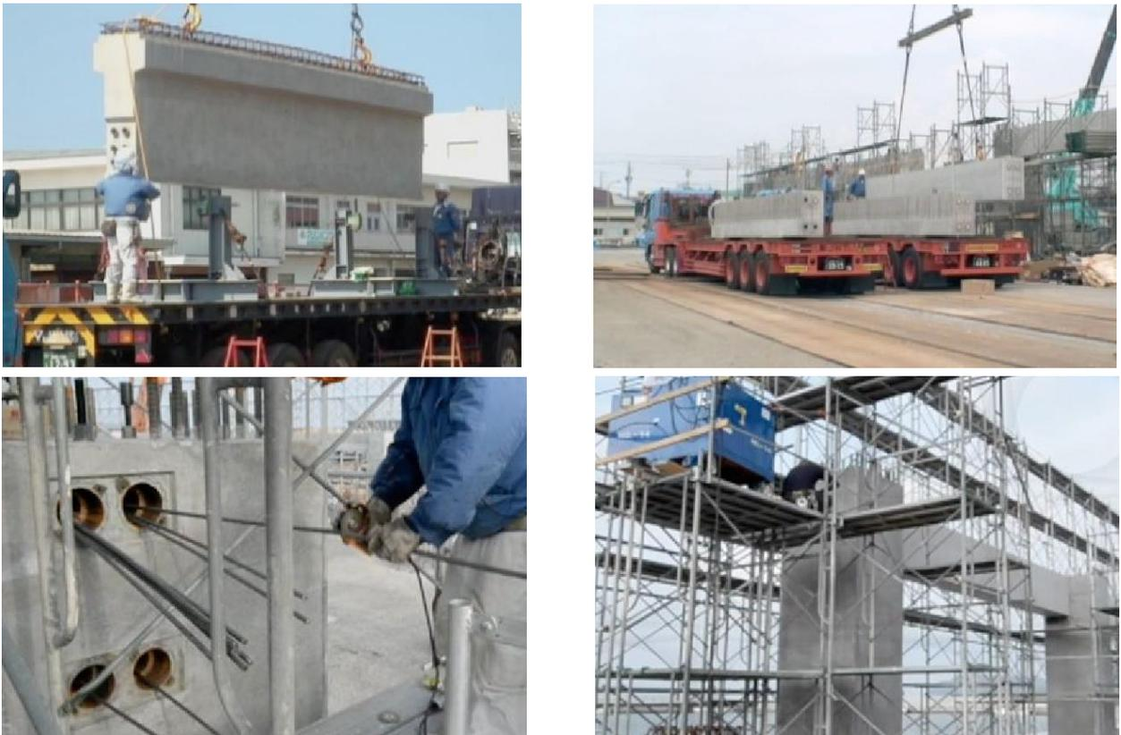
写真-4 梁部材架設状況
