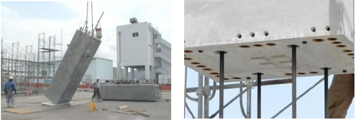
写真-3 柱部材架設状況
