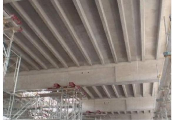
写真-6 DT床版施工状況
