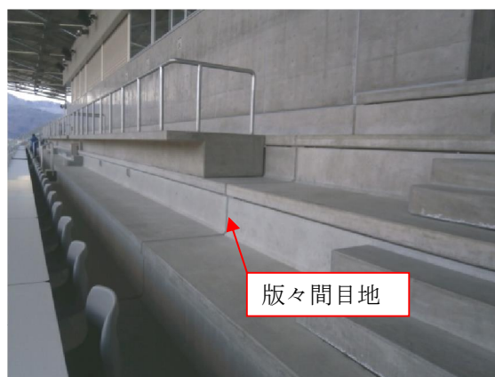
写真-3 段床版設置後状況
