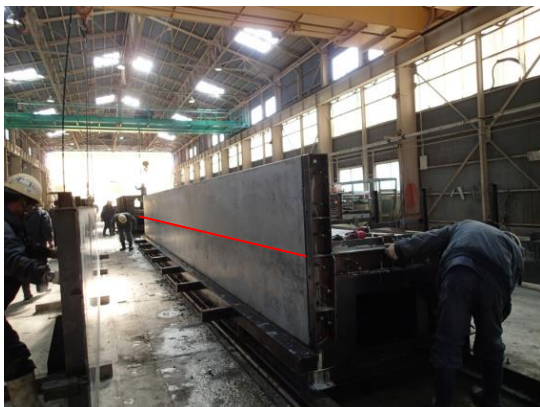
写真-5 段床版製作状況
