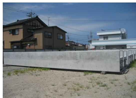
写真-6 段床版色違い状況
