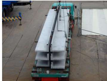
写真-8 標準段床版架設状況
