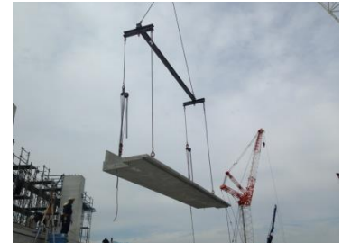
写真-9 吊り天秤使用状況
