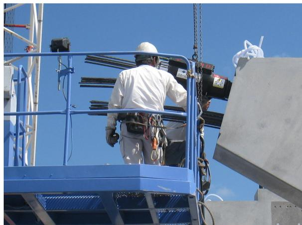
写真-14 片持ち梁先端緊張状況
