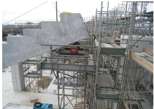
写真-9 中段 PC 段梁支保工
