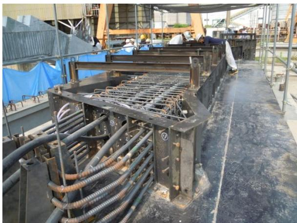
写真-2 型枠設置状況
