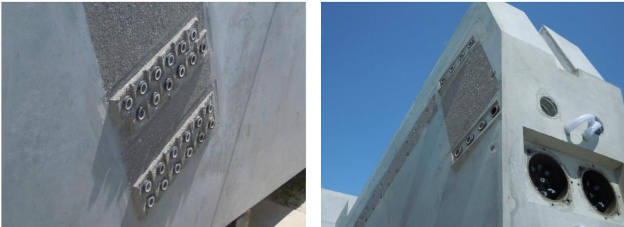
写真-15 メインスタンド棟 機械式継手埋め込み状況
