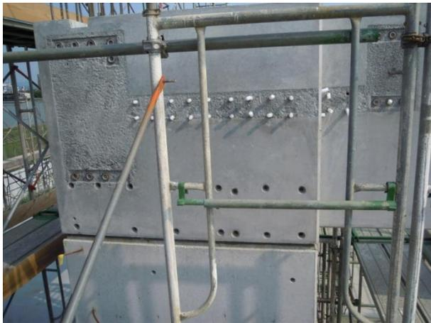
写真-12 PCa 柱梁接合部
