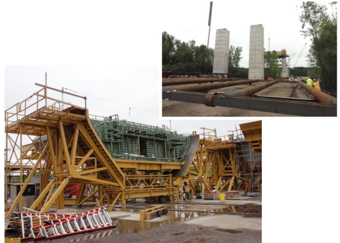
写真-6 施工中の橋脚およびセグメントヤード
