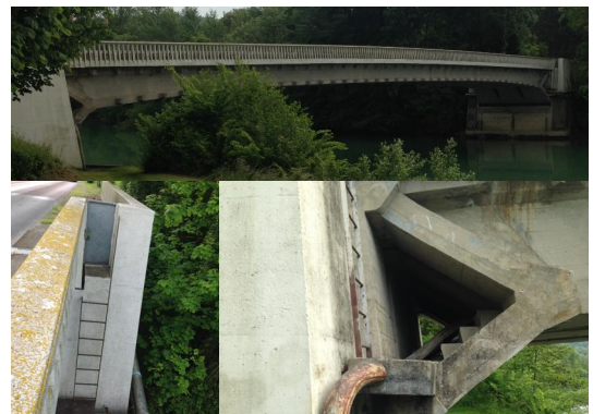
写真-9 ルザンシー橋の全景と検査路配置状況
