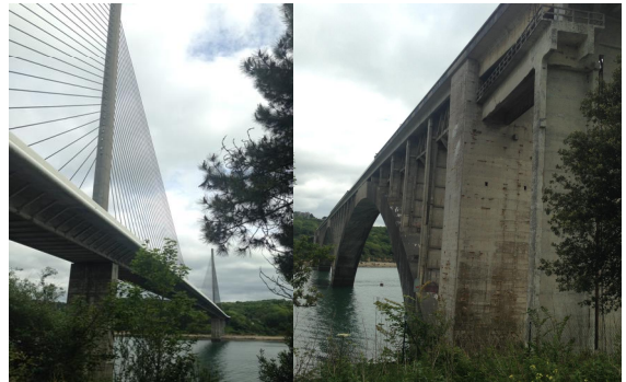
写真-8 プルガステル橋(右)とエルロース橋(左)
