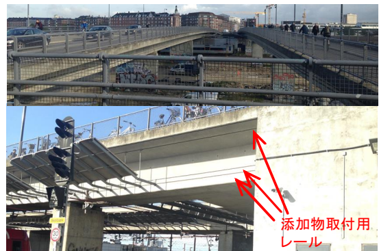
写真-4 コペンハーゲン市内の跨線橋
