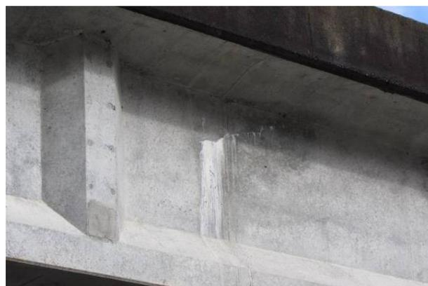
写真-2 主桁シースに沿ったひび割れ
