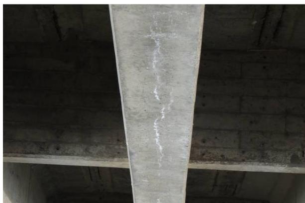
写真-1 主桁シースに沿ったひび割れ
