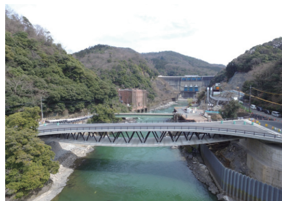
写真-5 完成写真
