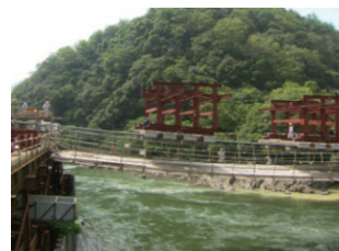
写真-1 吊床版ユニットの架設
