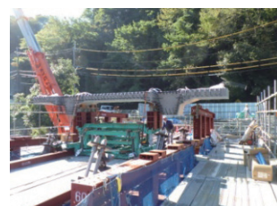
写真-3 上床版の架設
