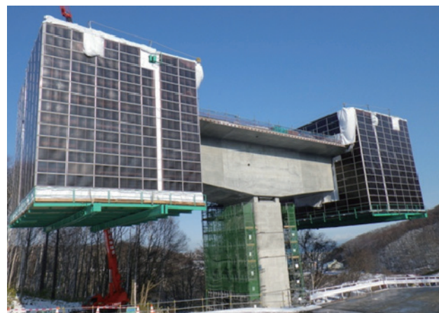
写真-1 移動式作業車の養生設備
