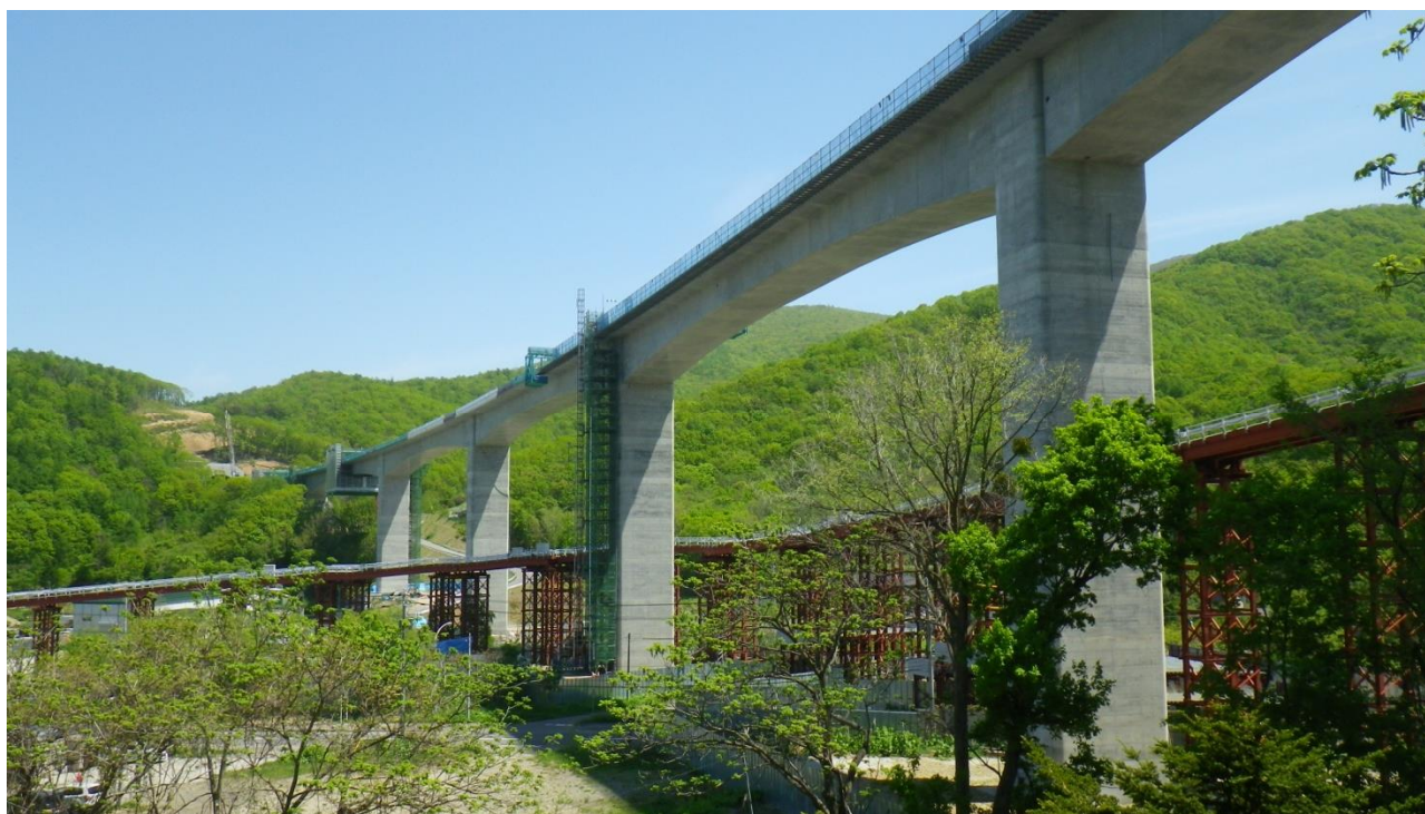
写真-7 橋梁全景（起点側から終点側を臨む）
