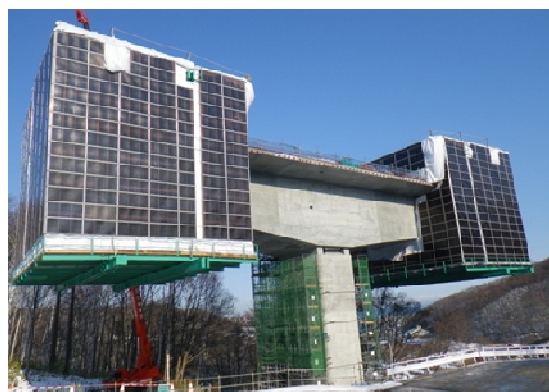
写真-1 移動式作業車の養生設備
