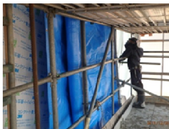
写真-3 保水養生テープの貼り付け
