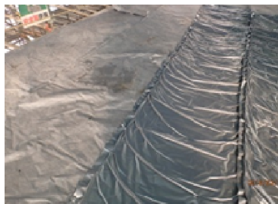
写真-2 高機能養生マットの敷設
