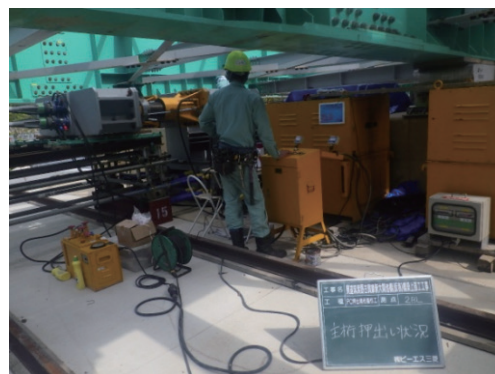
写真-2 押し出し状況(押し出し装置)
