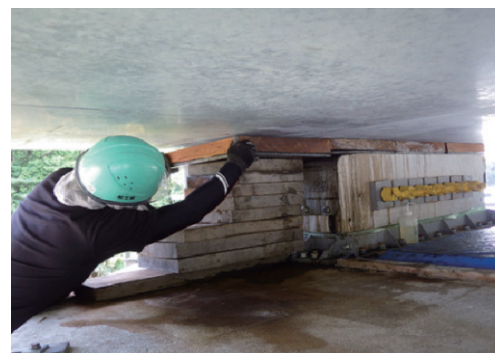
写真-3 押し出し状況(滑り支承部)
