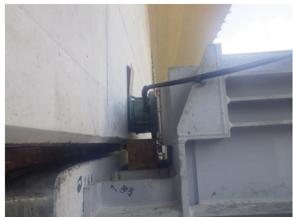
写真-8 横方向調整ジャッキ
