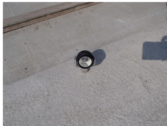
写真-6 橋面上のターゲット
