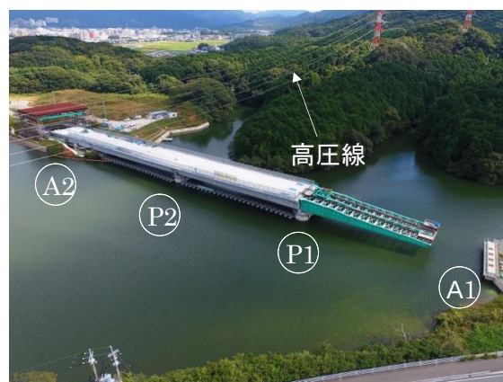
写真-1 押出し架設状況
