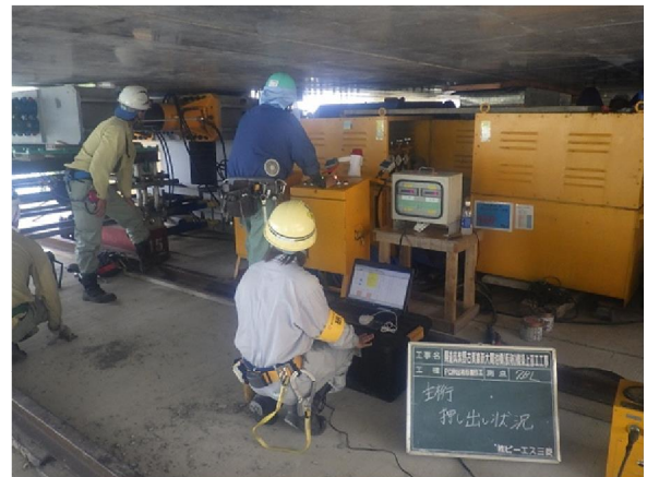
写真-7 押し出し量とジャッキ圧力の一元管理
