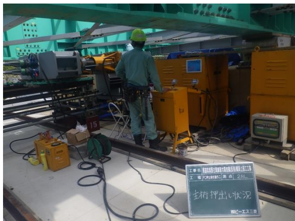
写真-3 押し装置
