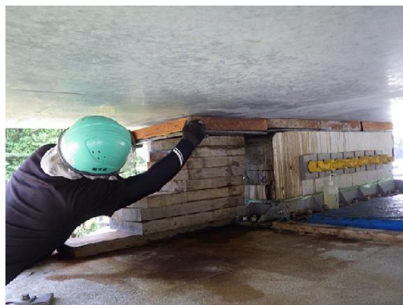
写真-4 押し状況(滑り支承部)
