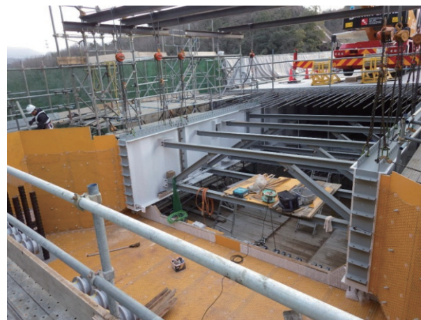
写真-1 A2側径間施工状況
