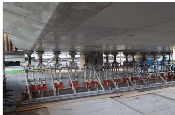
写真-4 仮支点設置状況
