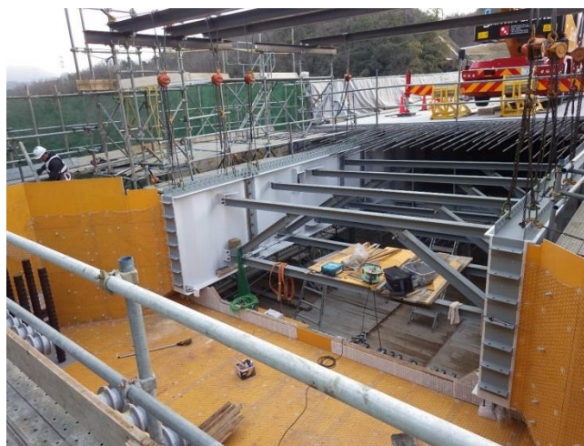
写真-1 A2 側径間における波形先行架設 および型枠組立状況
