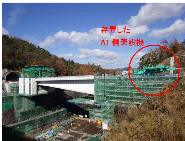
写真-3 A1 側架設機存置状況
