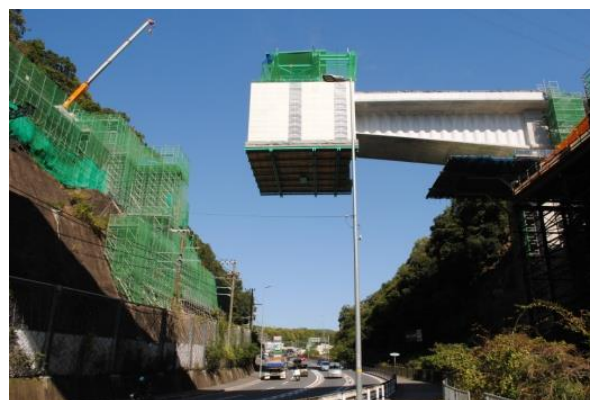
写真-5 国道上を通過する架設機
