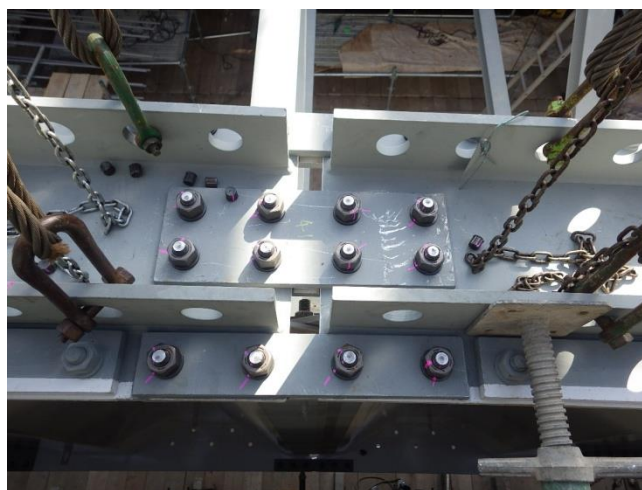
写真-2 波形鋼板ウェブ フランジ接合状況
