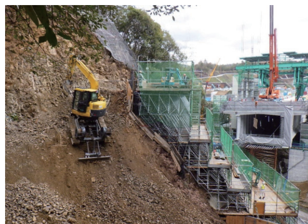
写真-4 クライミングバックホーによる掘削状況
