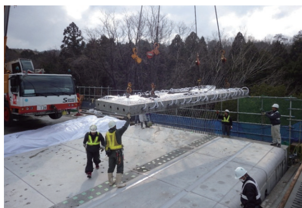
写真-3 プレキャスト延長床版架設状況
