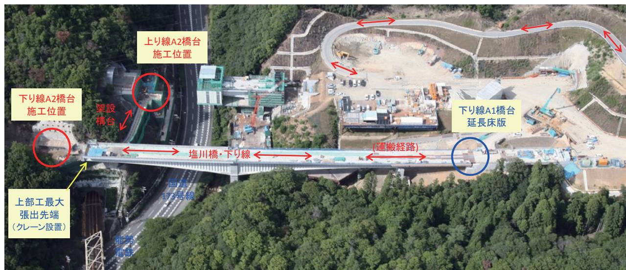
写真-2 下部工施工における掘削土の運搬経路
