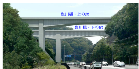
図-2 完成図(上:南より，下:北より)
