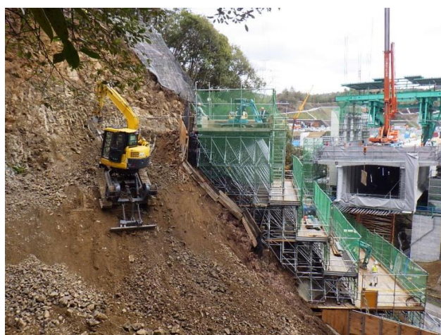
写真-6 クライミングバックホーによる掘削状況
