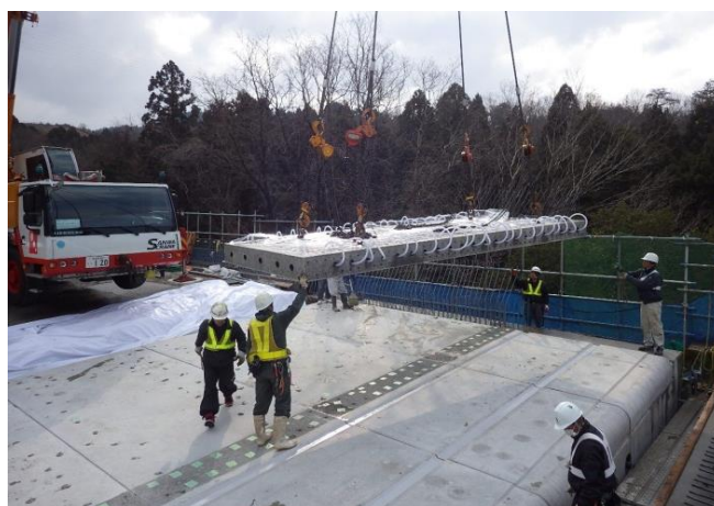
写真-4 プレキャスト延長床版架設状況
