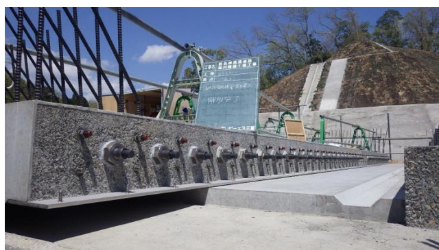
写真-5 NAPP 鋼棒緊張後の状況
