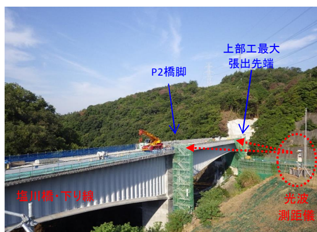
写真-1 下り線 A2 上部工の高さ計測状況
