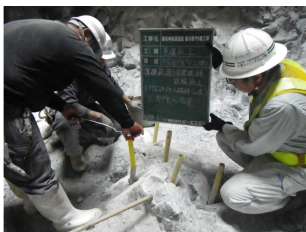
写真-3 プラズマカプセル破碎施工状況
