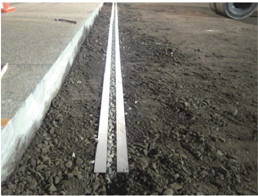
写真-2 路盤排水溝施工完了
