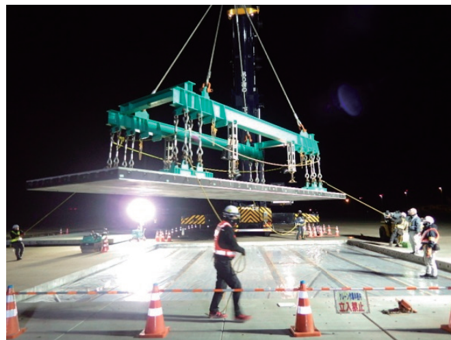
写真-1 PPC版敷設状況
