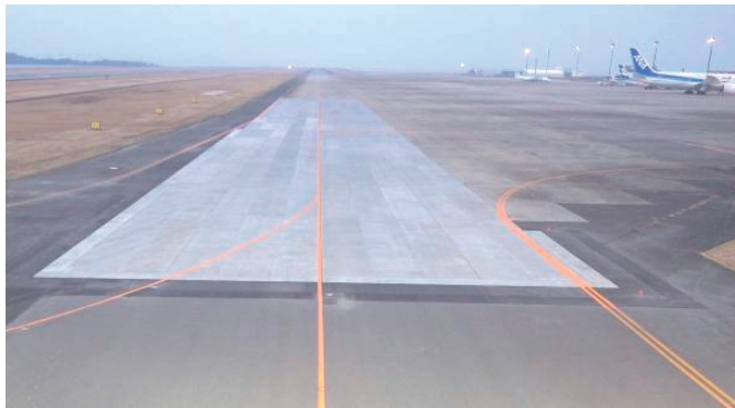
写真-3 施工完了全景
