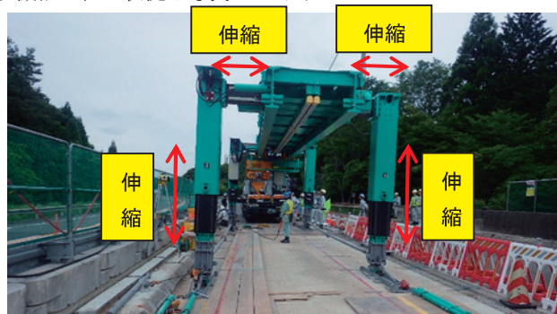
写真-3 架設機械の組立状況
