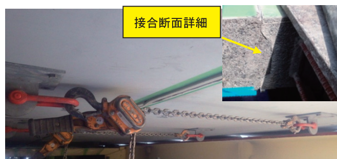
写真-5 プレキャスト PC 床版の引き寄せ・接合
