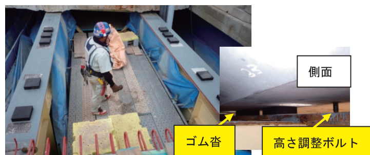
写真-4 仮受け材設置状況
