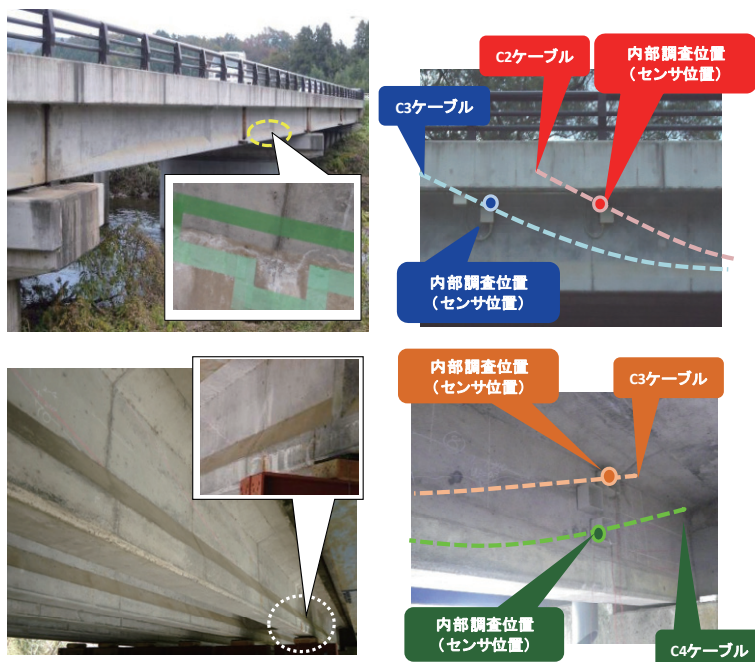
写真-1 対象橋梁の外観とモニタリング対象ケーブル (上: H 橋, 下: S 橋)
