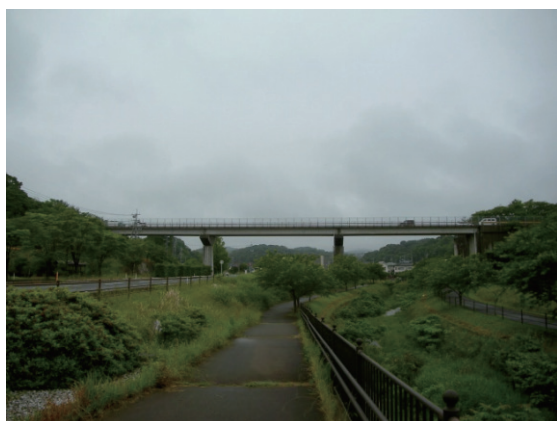
写真-1 片倉高架橋 全景
