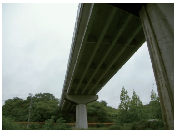
写真-2 片倉高架橋 下面
